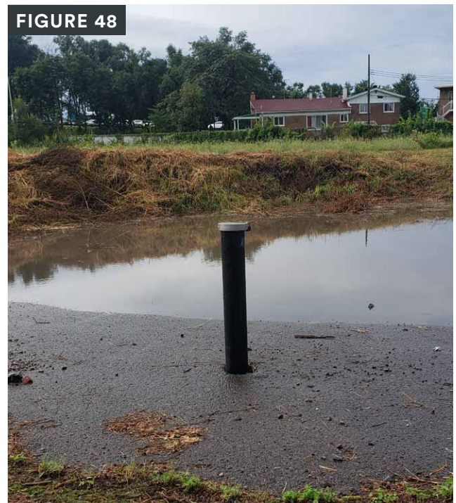
Élément de l'ancien bâtiment laissé sur le lot 5.9
