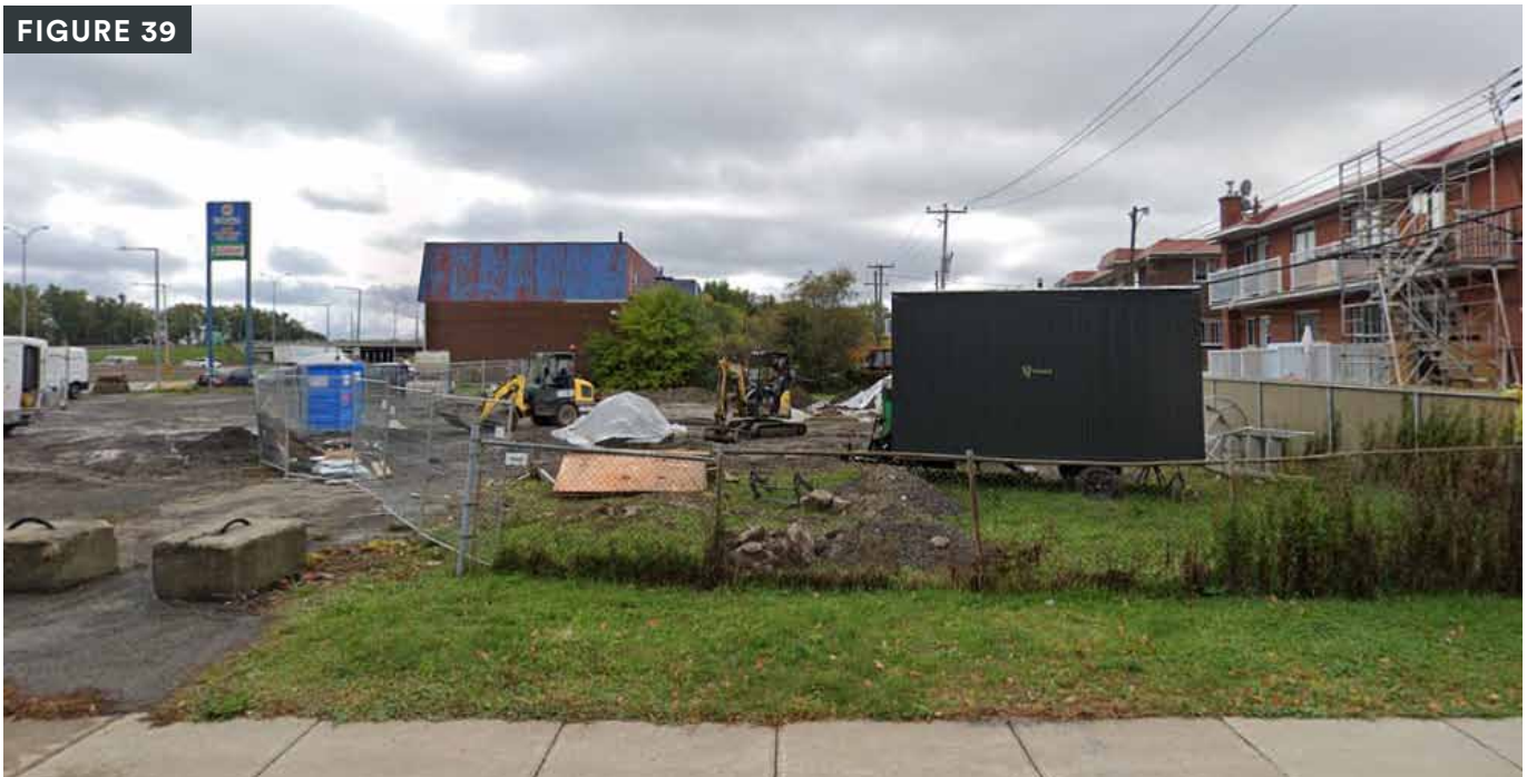
Travaux de décontamination en 2020
