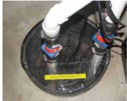
tout en étant étanche aux gaz. On installe ensuite un tuyau d'aspiration du radon sur ce couvercle. Si un avaloir de sol du sous-sol est raccordé au puisard, un garde d'eau mécanique ou un drain capable de laisser écouler l'eau mais étant étanche aux gaz devrait être installé pour empêcher l'air intérieur de pénétrer le puisard par l'avaloir.
