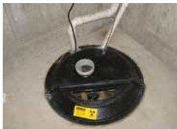
**Avaloirs de sol** – Les avaloirs de sol du sous-sol peuvent comporter des clapets spéciaux installés pour permettre à l'eau de s'écouler, mais d'empêcher le radon de s'infiltrer dans le sous-sol. Ces clapets spéciaux ne sont pas un substitut pour une soupape antirefoulement. Ces dispositifs tiennent également à distance moisissures, mauvaises odeurs, insectes et courants d'air froid.
