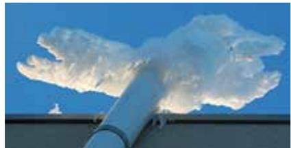
Sous divers climats au Canada, un ventilateur et un tuyau placés à l'extérieur des aires habitées (garage ou grenier) rafraîchiront pendant les mois les plus froids de l'année, entraînant ainsi de la condensation et possiblement la formation de glace, ce qui endommagera le ventilateur et diminuera l'efficacité du système d'atténuation du radon.
